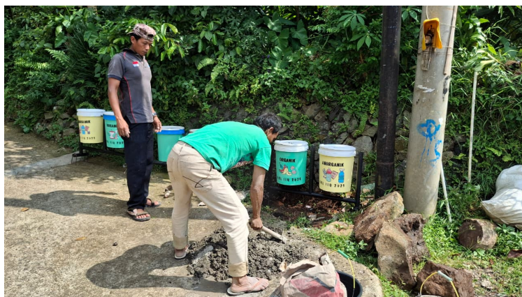
Gambar 1. Penanaman Kerangka Tempat Sampah
